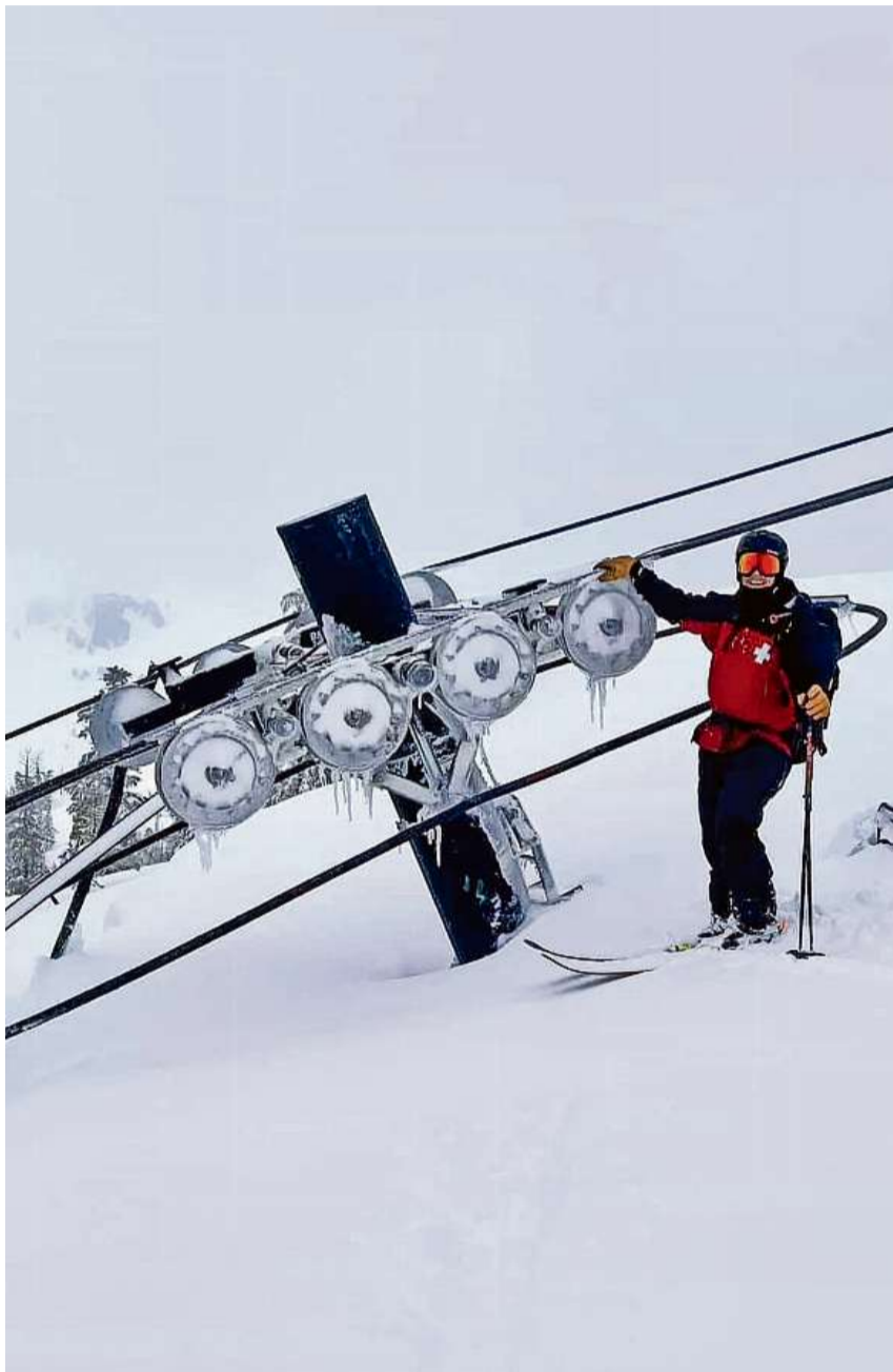
In Mammoth Mountain (Kalifornien) wurden die Sessel eingeschneit. Es gab Schnee bis zu den Rollenbatterien , 22 Meter Schneehöhe. (FOTO ZVG)
